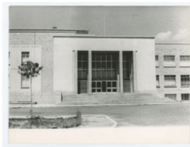
(Figura 1. Fachada de la Escuela Superior de Bellas Artes de San Fernando, Fotofiel)
