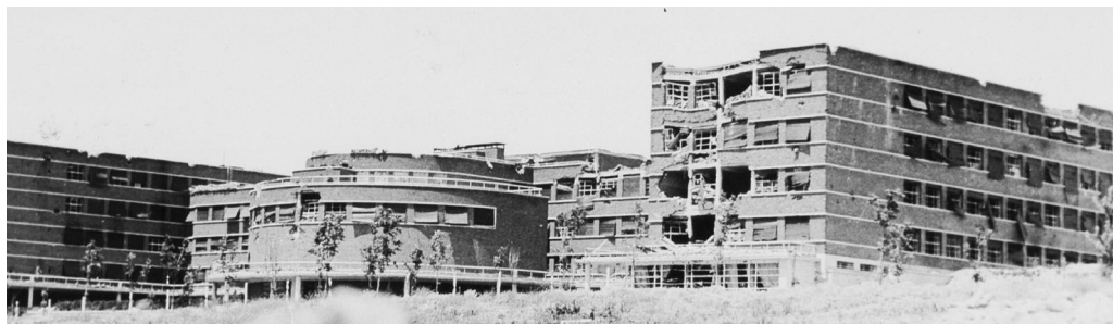
Fachada posterior de la Facultad de Filosofía y Letras dañada durante la guerra civil por los impactos de los obuses.
