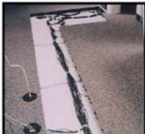
Suelo técnico de perfil bajo con cableado bajo los paneles
