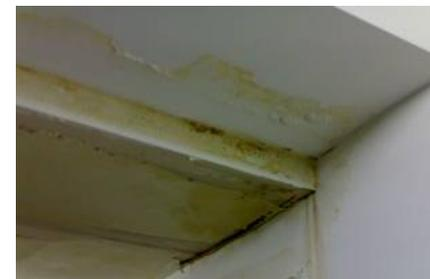
Atención a las filtraciones o goteras en la fijación o anclajes de los equipos
