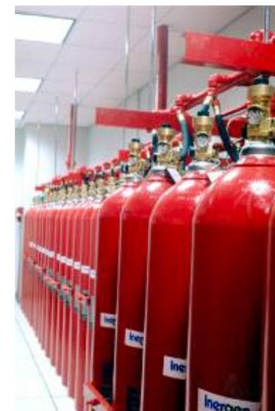
Argonite usado en un sistema automático de extinción
