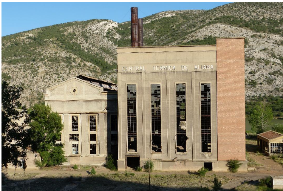
Figura 1. Antigua Central Térmica de Aliaga, Teruel. Fotografía propia.
