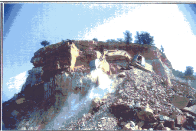
Foto 8.3. Ejecución del proyecto. Desmonte de grandes bloques inestables, deslizados traslacionalmente del antiguo frente de explotación.
