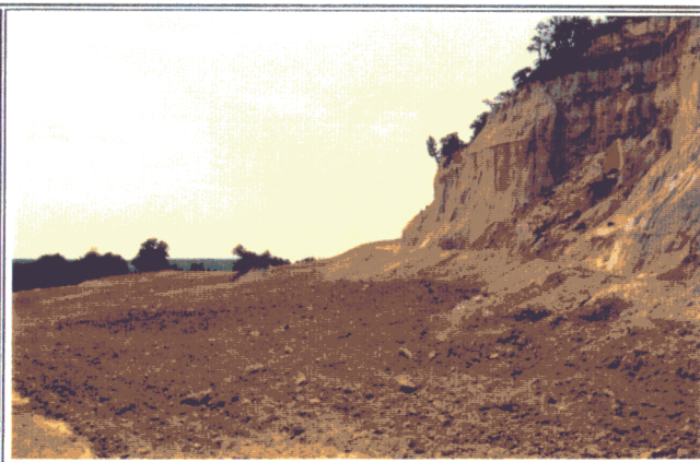
Foto 8.5. Talud de derrubios adosado al antiguo frente de explotación. El diseño elaborado contempla la evolución de la ladera por fenómenos gravitacionales de este tipo, y su consiguiente tendencia a la regularización.
