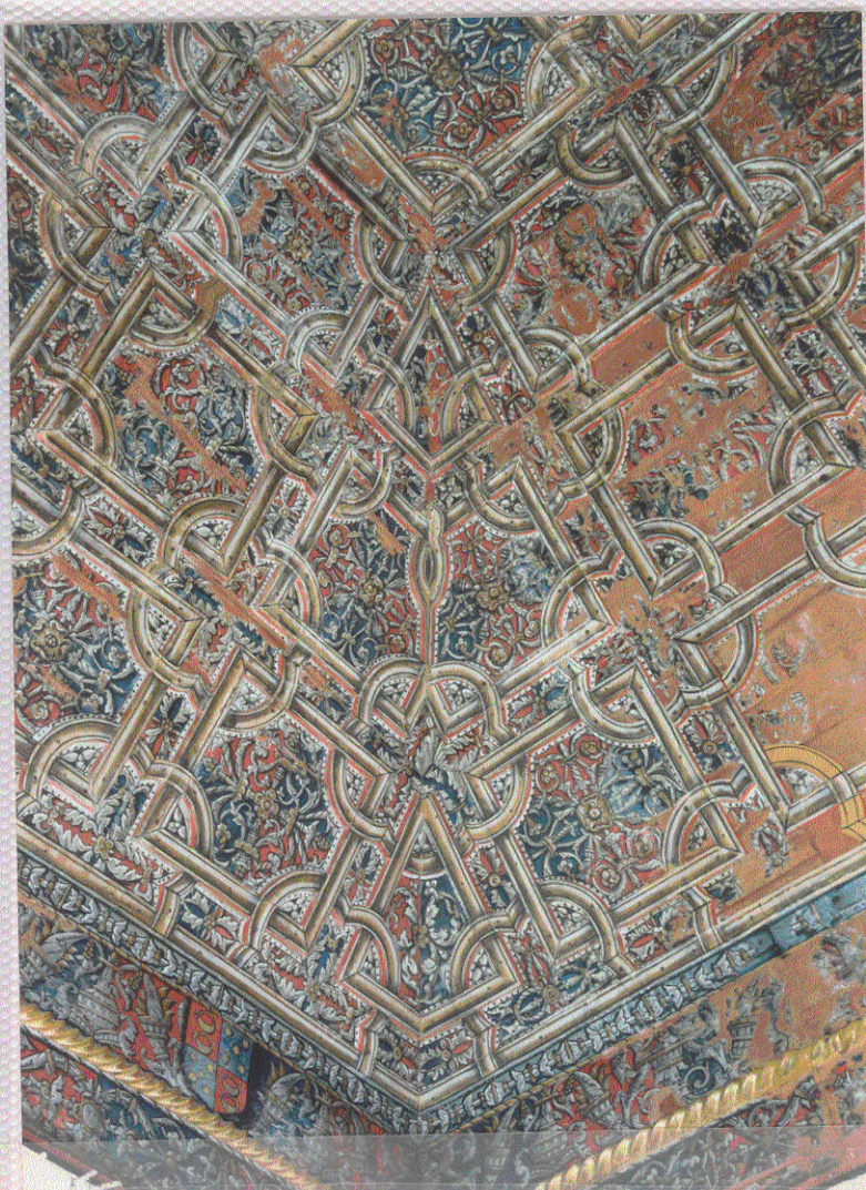
335. - MEDINA DE POMAR: Convento de Santa Clara. Armadura de limabordón de la antigua Sala Capitular.
