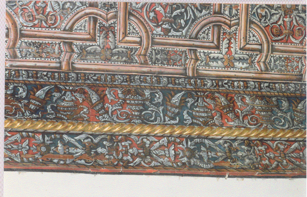
332.- MEDINA DE POMAR: Convento de Santa Clara. Doblo aliger de la armadura
