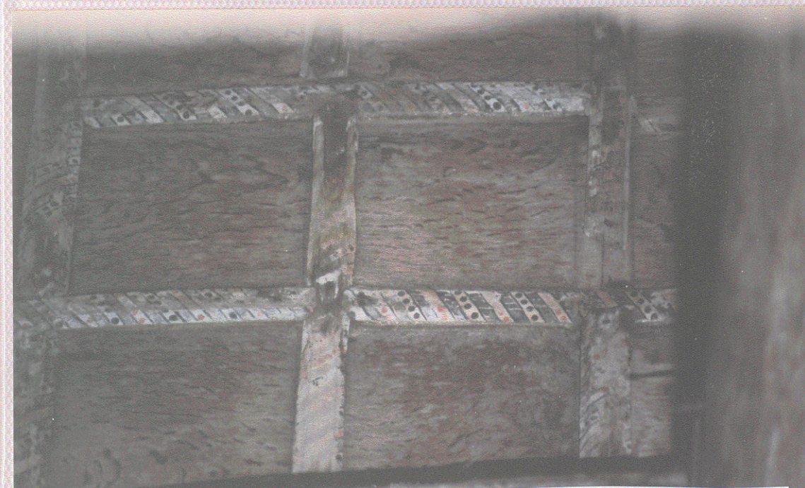
331.- MEDINA DE POMAR: Convento de Santa Clara. Armadura que actualmente se
