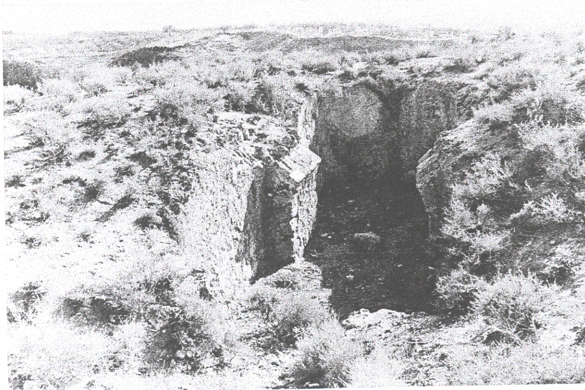
Arranque de una bóveda. Estructuras de mampostería.
