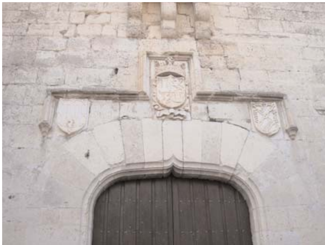
Fig. 5 Puerta de acceso al castillo de Cuéllar (Segovia). Detalle de los escudos. A la izquierda, el de la familia Cueva.
