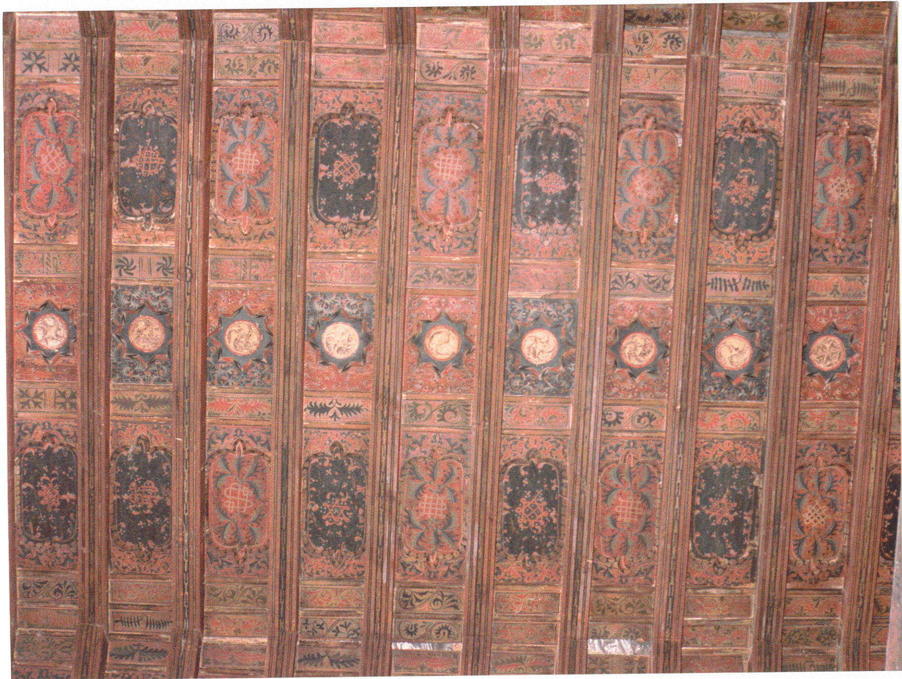
922.- SINOVAS: San Nicolás de Bari. Detalle del almizate de su armadura de par y nudillo. Comienzos del siglo XV. Escuela de carpintería gótico mudéjar burgalesa.
