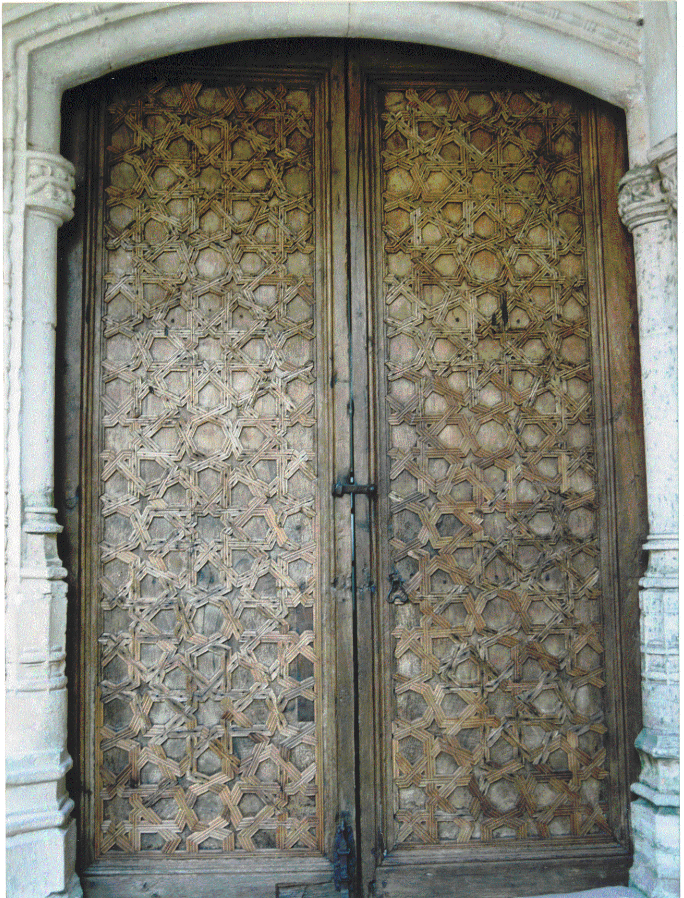
924.- MEDINA DE POMAR: Convento de Santa Clara. Puerta mudéjar con decoración geométrica de lazo ataujerado de ocho de la antigua sala capitular. Primera mitad del siglo XV. Escuela de carpintería gótico mudéjar burgalesa.
