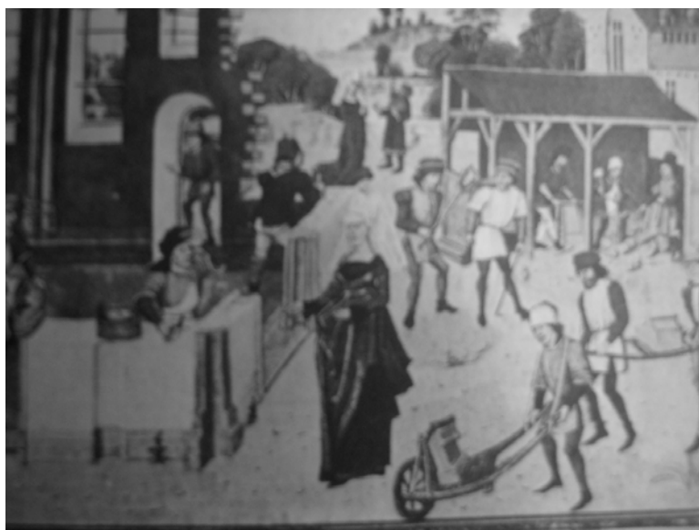
Ilustración 12: construcción de la iglesia de la Magdalena, en Borgoña con el cobertizo al fondo
