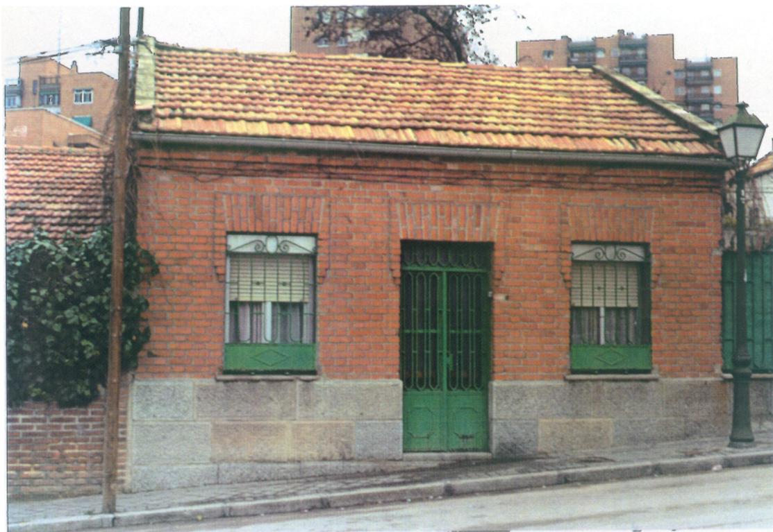
**Foto 11.- En las primeras viviendas unifamiliares un signo de calidad es la construcción de la parte baja del edificio con bloques de granito, que dan aspecto de mayor solidez.**
