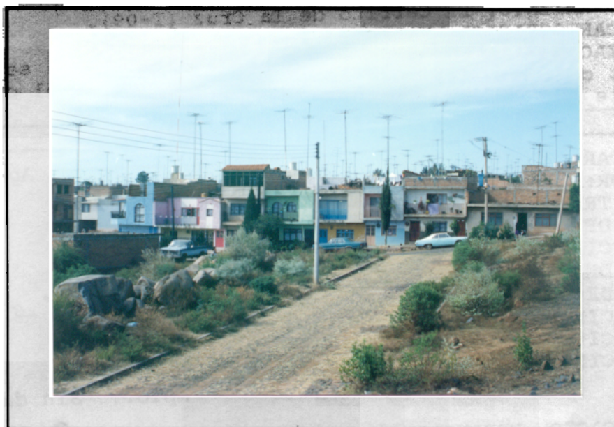
Foto 17. Un modelo densificado de autoconstrucción en fase avanzada de consolidación (23-XII-91).
