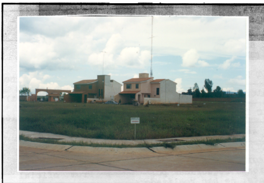
Foto 20. Las obras de urbanización han concluido. Los predios fueron vendidos en su mayoría y sólo hay dos casas (11-X-92).
