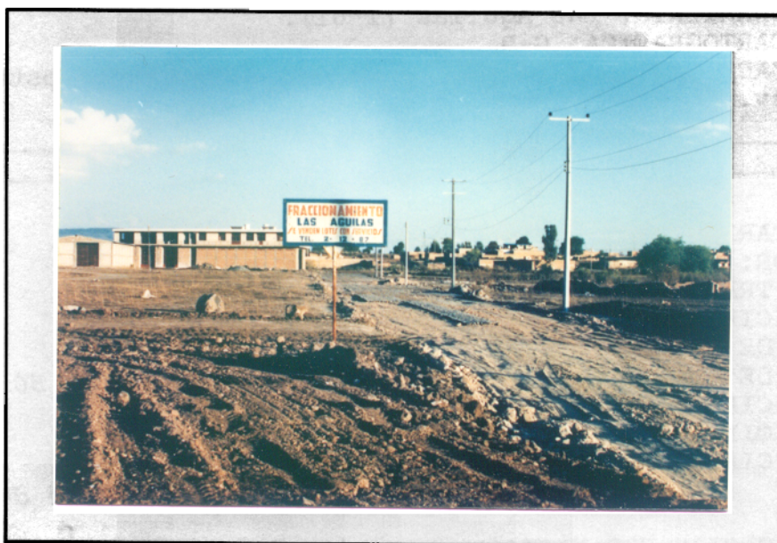
Foto 1. "Se venden lotes con servicios". Inicio de las obras de urbanización (9-III-90).
