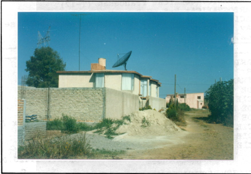
Foto 23. Espacios privados mal acoplados con la calle. (8-XII-90).
