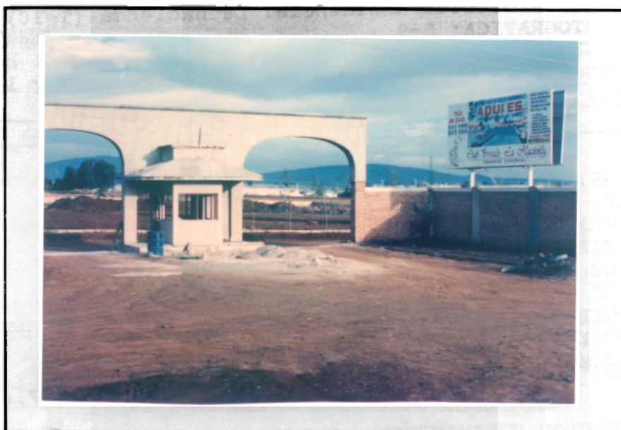
Foto 19. Publicidad, barda perimetral e ingreso, los pasos iniciales de un estilo de urbanización difícilmente asociable a Tepatitlán (9-II-90).
