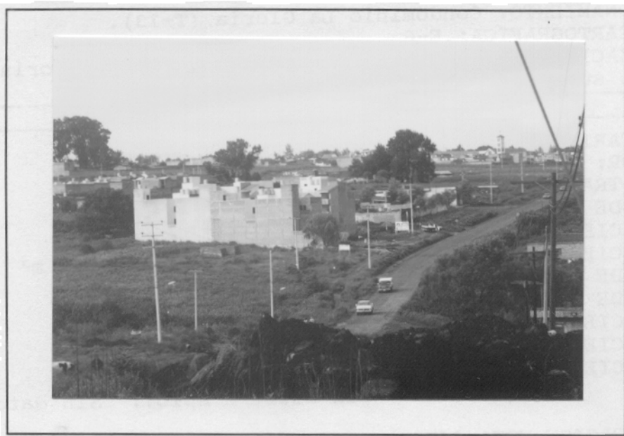
Foto 25. El primer bloque de viviendas tepatitlense en su fase constructiva (17-VIII-91).
