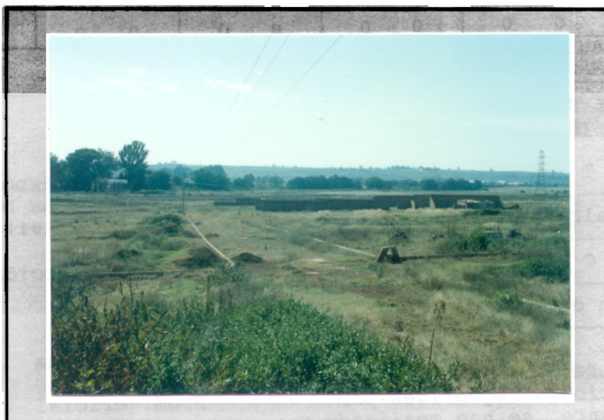
Foto 8. Las obras del viario, apenas esbozadas, reflejan cierto abandono (8-XII-90).
