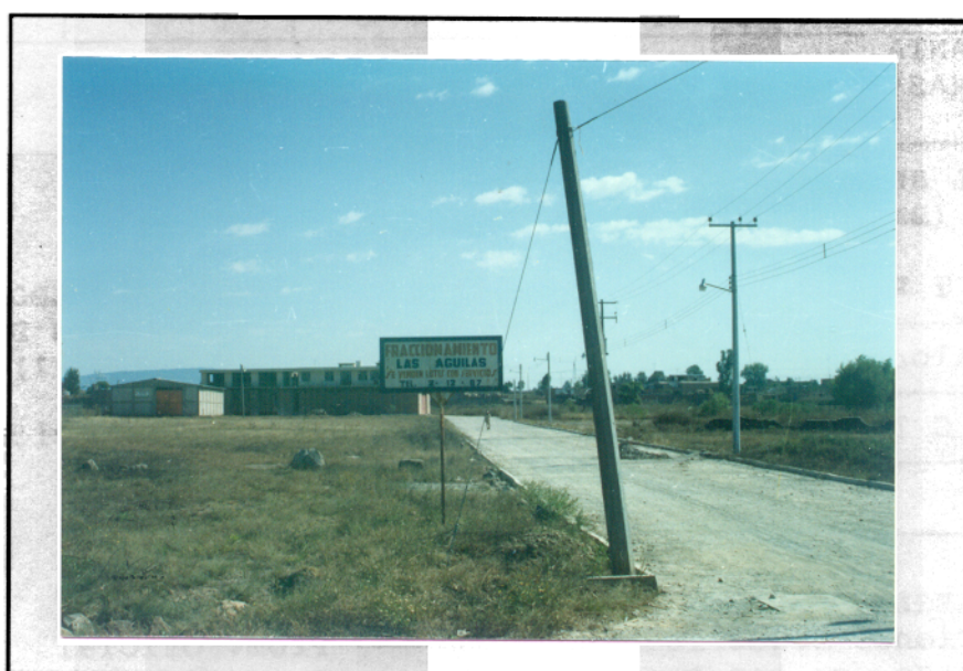
Foto 2. 11 meses después. Destaca la precariedad de las obras (8-XII-90)
