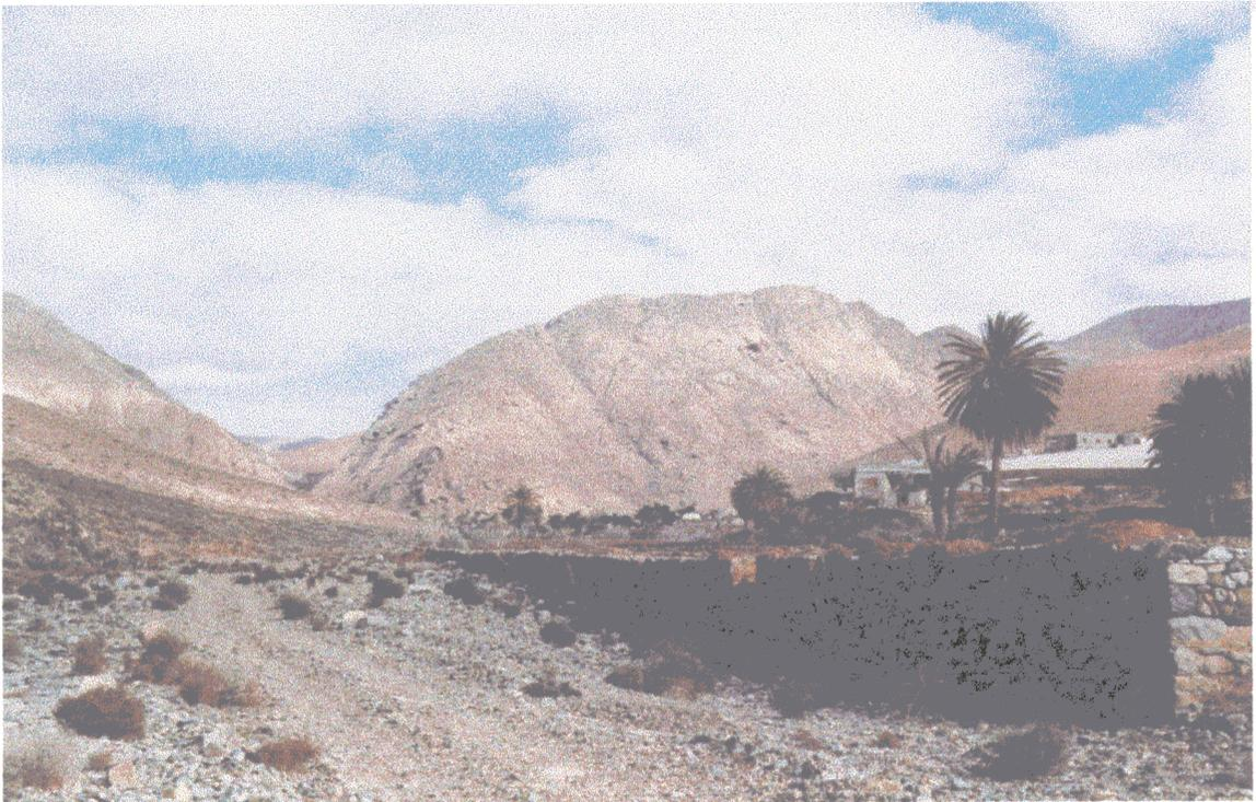
Fotografía 18.6: Vista desde el sur (hacia el norte) de la cerrada del Embalse de las Peñitas, construida sobre afloramientos de traquitas. Nótese el macrodiacclasado espectacular y su orientación: NNE-SSO para las de *tipo I* y NO-SE/NE-SO para las de *tipo II*.
