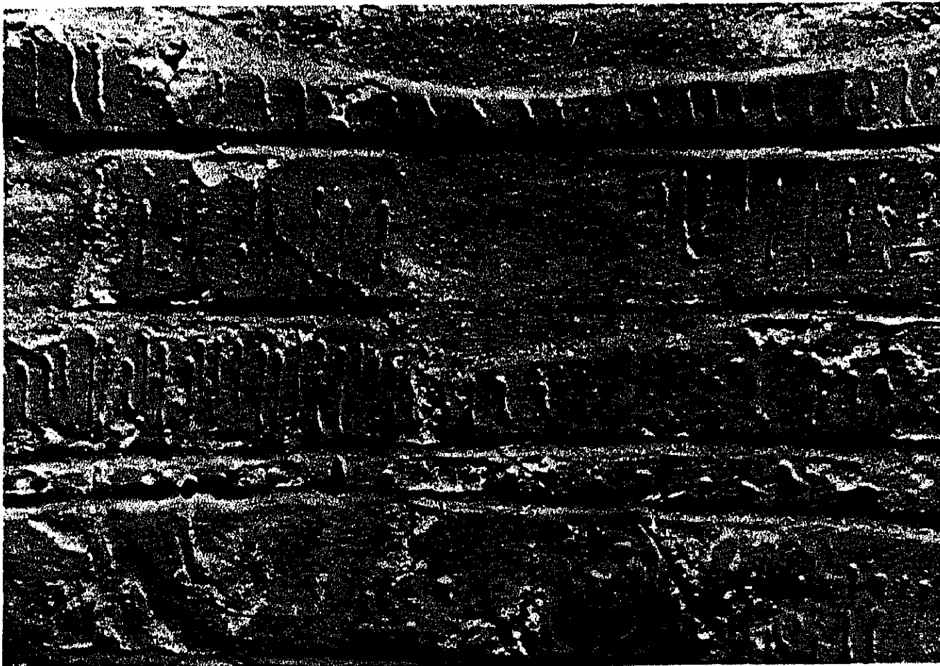
Fots. 19 y 20. Ejemplos de craqueladuras, grietas y levantamientos de color producidos ante la imposibilidad de que la espesa capa pictórica se adapte a las oscilaciones higrométricas del soporte.
