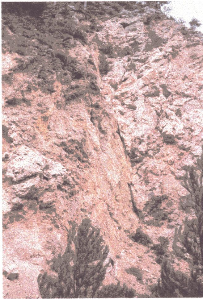
Fotografía 10.7: Plano de falla normal localizado en las proximidades de un frente de cabalgamiento en el interior del Arco de Alcaraz (al norte de Riopar). En este área se han registrado planos de falla estriados que se acomodan a un tensor de esfuerzos extensivo ( \sigma_1 vertical y \sigma_2 dispuesto NO-SE).
