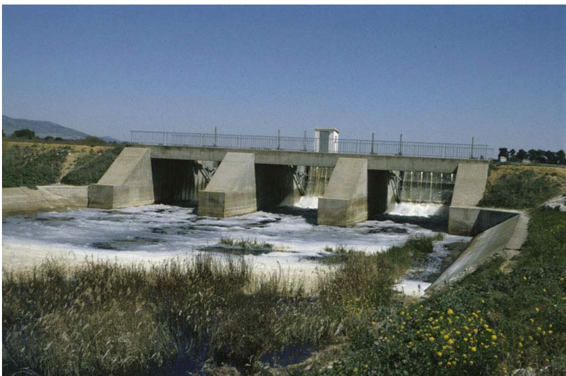
Foto 4.1. Presa de Puente Navarro en la parte suroccidental del Parque Nacional de las Tablas de Daimiel
