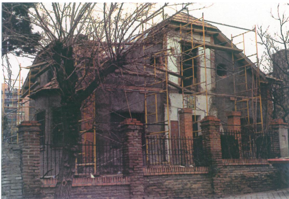
**Foto 15.-** Rehabilitación de un antiguo chalé en Valdeconejos. Las obras afectan tanto a la fachada como al interior, preservando la forma inicial pero adecuando la vivienda no sólo a unas mejores condiciones de habitabilidad, sino también al nivel y características del entorno.
