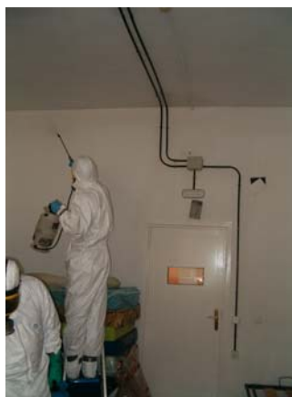
Tratamiento biocida paramentos/otros elementos (Fotografías UTCV-Madrid Salud)
