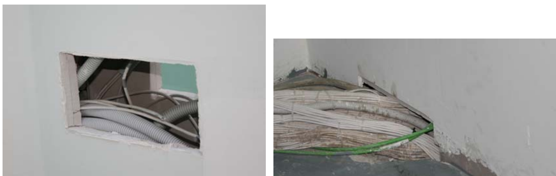
Espacios perdidos murales provocados por el doble tabicado. (Fotografías UTCV-Madrid Salud)
