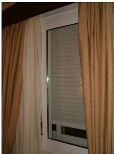
Ventana (PVC). (Fotografía UTCV-Madrid Salud)
