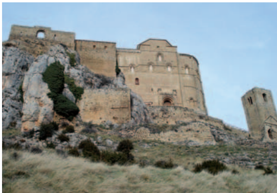
Fig. 10. Vista de conjunto en la actualidad tras la eliminación del tejazoz de la puerta de ingreso. Foto: Alex Garris Fernández.
