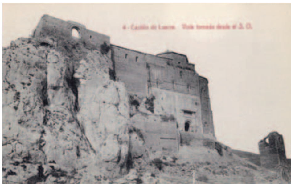
Fig. 9. Ingreso al castillo tras la eliminación de la hospedería adosada anteriormente y colocación del tejazoz sobre la portada. Fotografía M. Arribas / AFIAA. Diputación de Huesca. 1911-1920.
