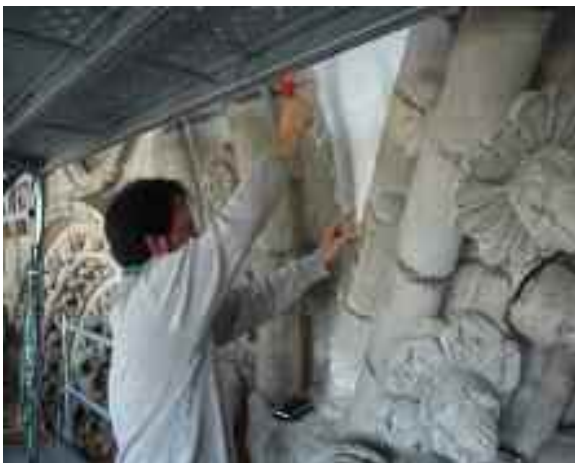
Figura 14. Ensayos de consolidación. Fotografía: Área de Intervención del IPCE.
