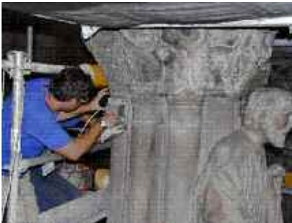
Figura 10. Colocación de sensores para la monitorización estructural. Fotografía: Coo.be.c.
