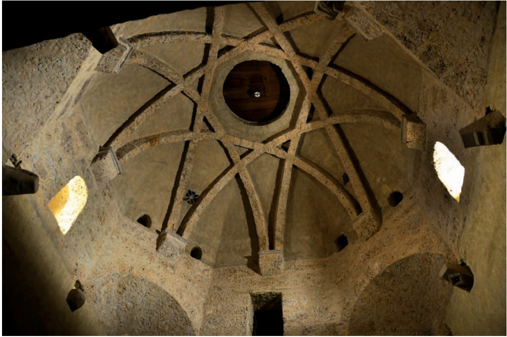
Fig. 10. L'Hôpital Saint-Blaise, bóveda sobre el crucero
