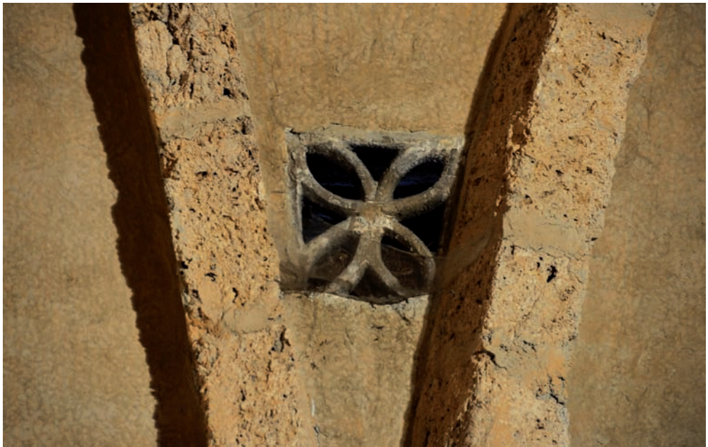
Fig. 11. L'Hôpital Saint-Blaise, celosía cruciforme
