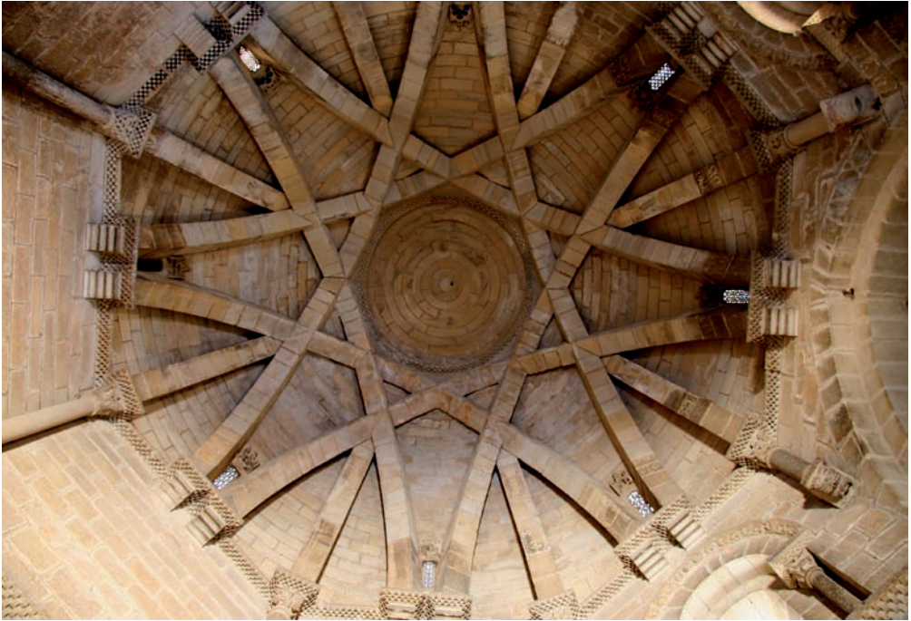
Fig. 6. Torres del Río, bóveda de entrecruzamiento periférico
