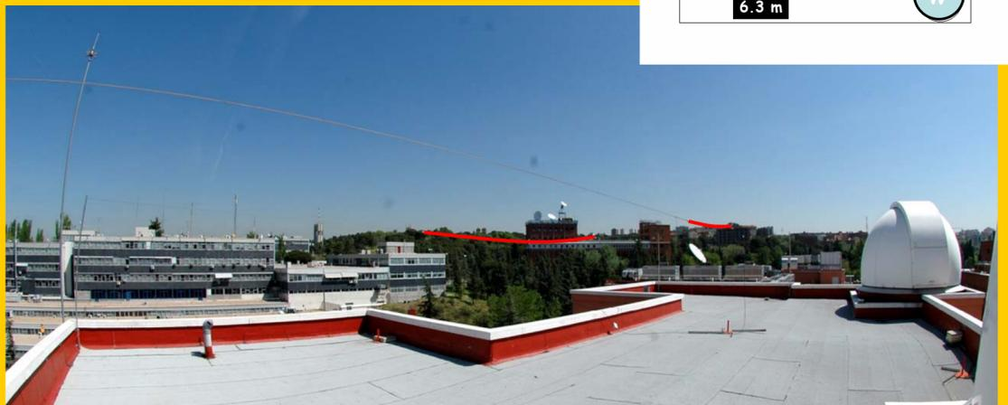
Vistas del radiotelescopio de la UCM en la terraza de la Facultad de CC. Físicas al norte de las cúpulas que albergan los telescopios ópticos. Los dipolos, que se sujetan con cables desde los extremos de la terraza, se han marcado con una línea roja en la imagen superior.
