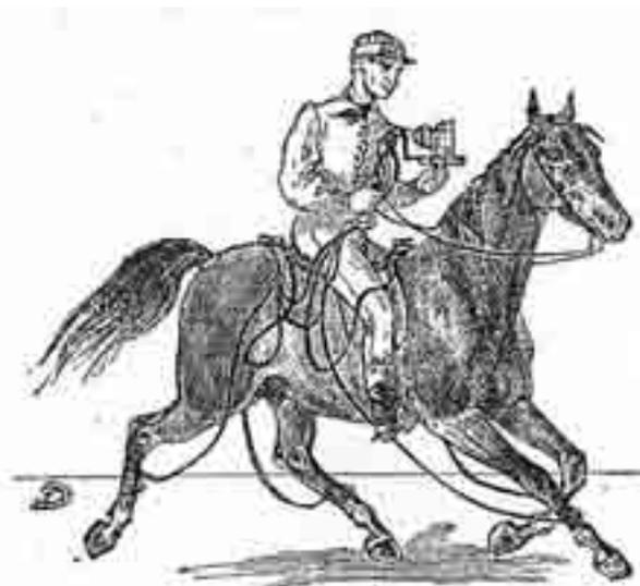
Fig. 138. Instrumento para medir el movimiento de las patas de un caballo. E. J. Marey. 1874.
