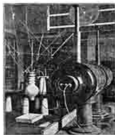
Fig. 98. Aparato para descarga eléctrica destinado a conseguir la transmutación de mercurio en oro.. Sugiura, Asada y Machida. 1924.
