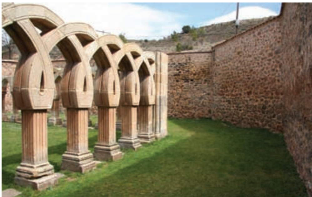
Fig. 19. Muro perimetral achaflanado.
