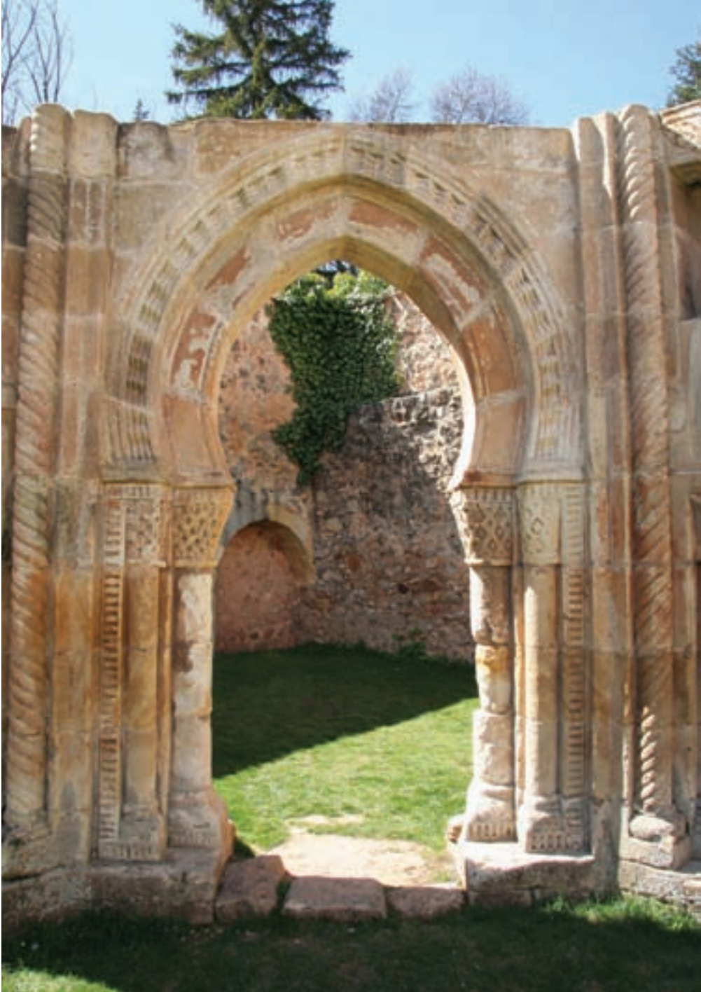
Fig. 23. Puerta de esquina con columnas torsas.
