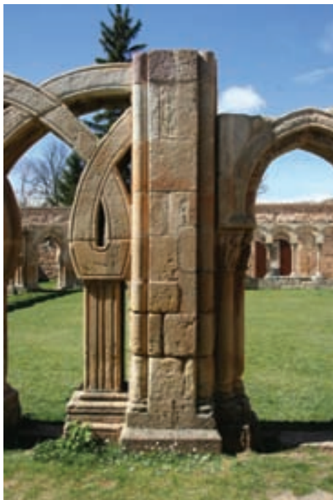
Fig. 11. Machón central de la galería oriental.
