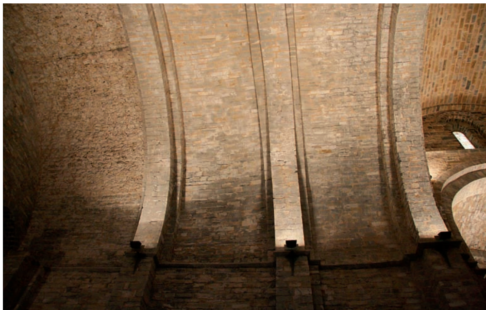
Fig. 5. San Pedro de Siresa. Bóvedas de la nave longitudinal (a la izquierda la reconstruida en el siglo XIII)
