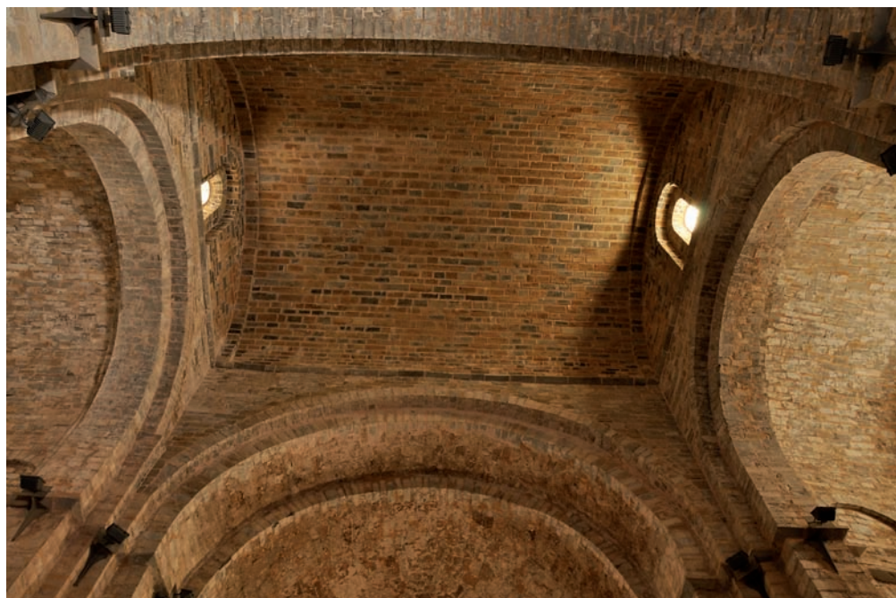
Fig. 4. San Pedro de Siresa. Bóveda de cañón sobre el crucero construida por Alcubierre
