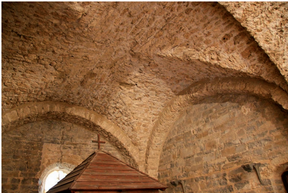
Fig. 10. San Pedro de Siresa. Bóveda de arista de la tribuna
