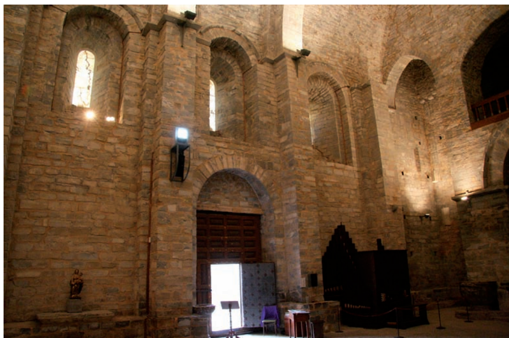
Fig. 12. San Pedro de Siresa. Ventanas de la nave longitudinal vistas desde el interior
