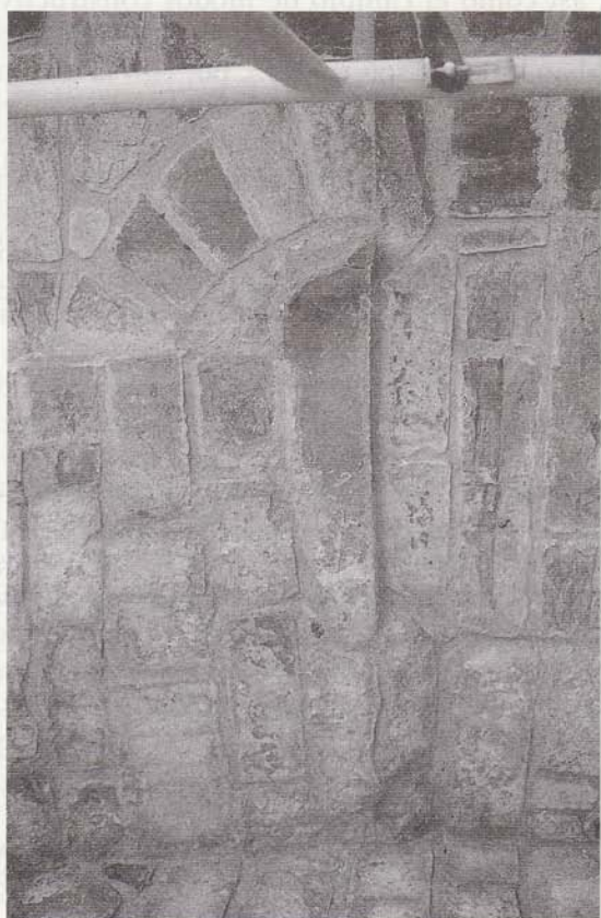
Fig. 18. San Pedro de Siresa. Puerta condenada por el forro de la nave, en el lado sur del cuero.
