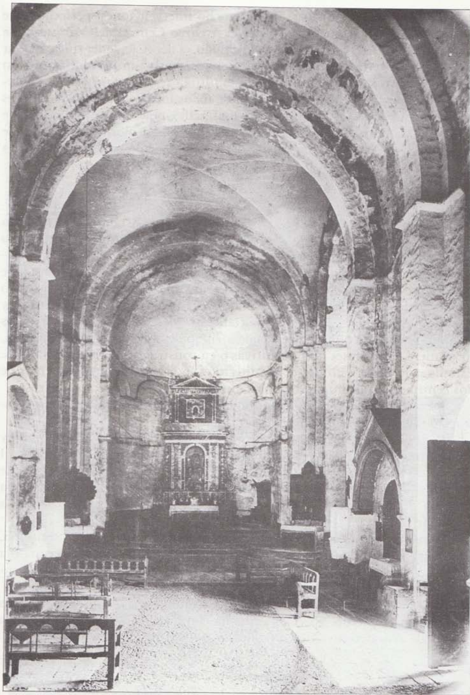
Fig. 2. Panorámica interior de nave central y ábside. Vista de las diferentes bóvedas, de aristas en crucero; el enlucido de Yeso cubre la totalidad de muros y bóvedas. Año 1917.
