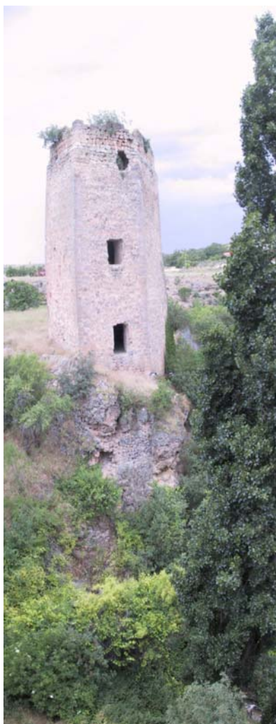
Fig 5. Torre de Despeñaperros del Castillo de Priego.
