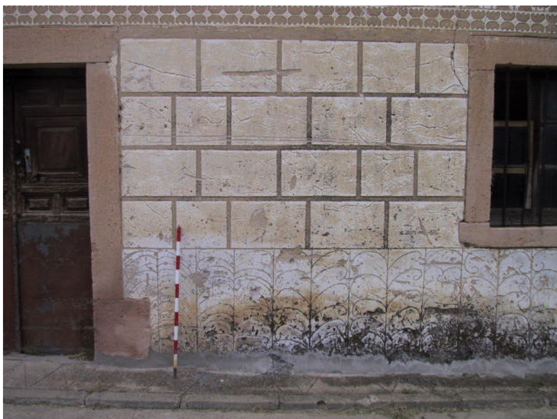
Fig 22. Detalle de la superposición de capas de enlucido en el interior de la explotación agrícola de Priego. En la fotografía no se aprecia, pero la segunda capa, ejecutada en cal, presenta decoraciones incisas muy semejantes a las de corte modernista, que se pueden apreciar en la foto inferior, que es de una de las viviendas del Aldeonsancho (Segovia, en las cercanías de Sepúlveda).
