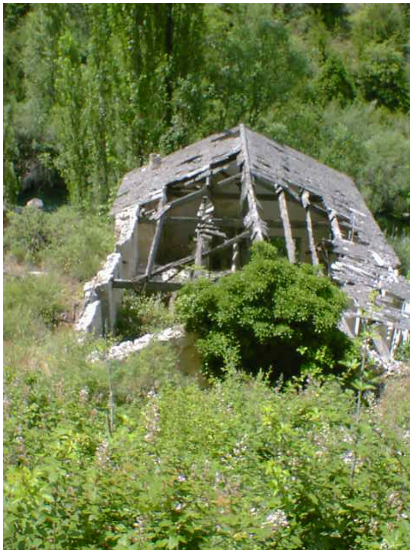
Fig 17. Tejado de la fábrica de luz que queda fuera de la zona de ampliación.
