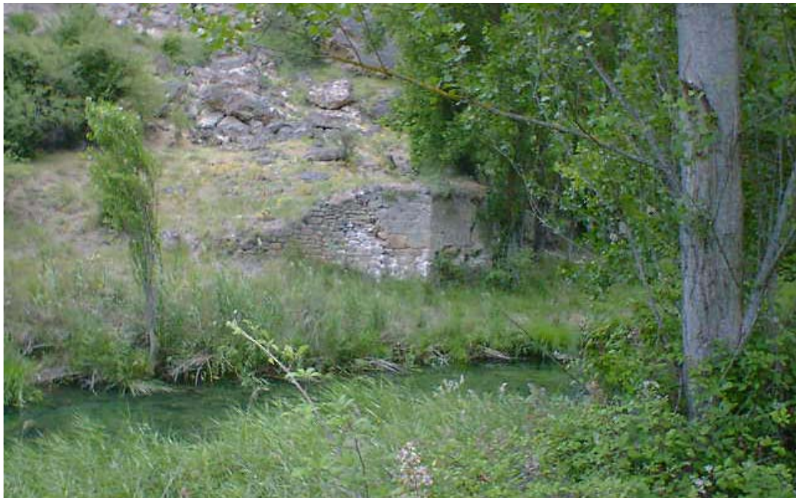
Fig 36. Puente arruinado a la altura de la parcela 306.
