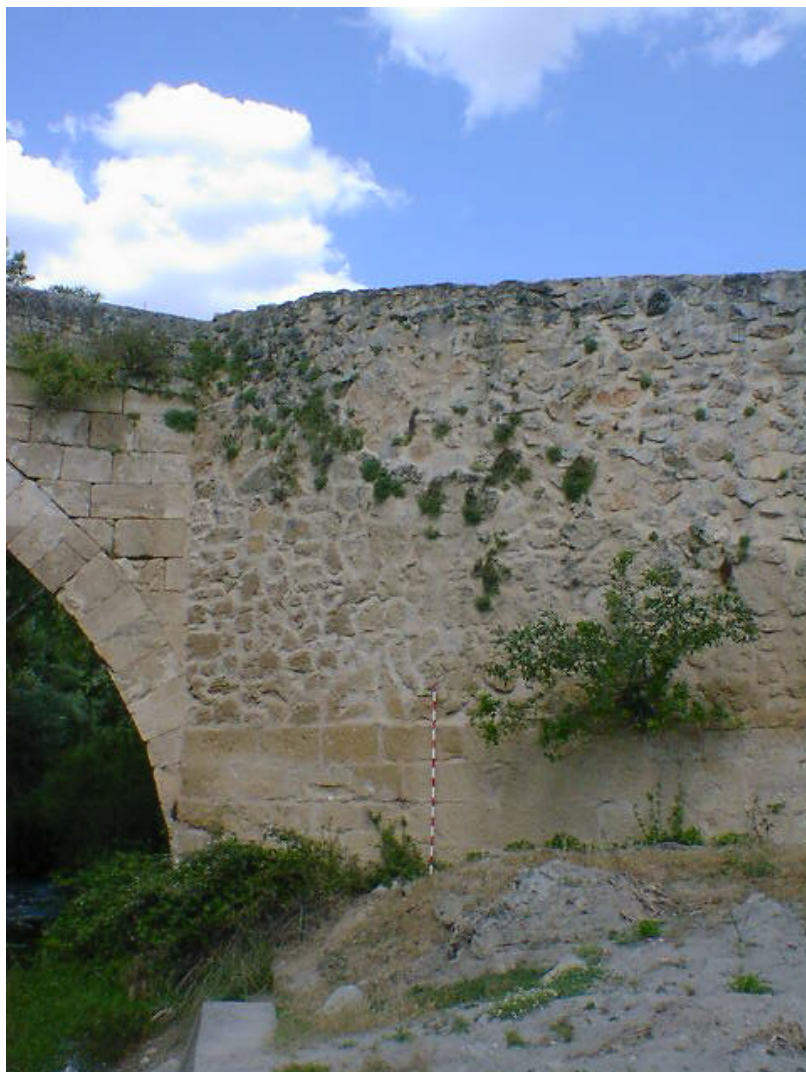
Fig 28. Estructura de subida al Puente del Allende, quizá construida en 1632.
