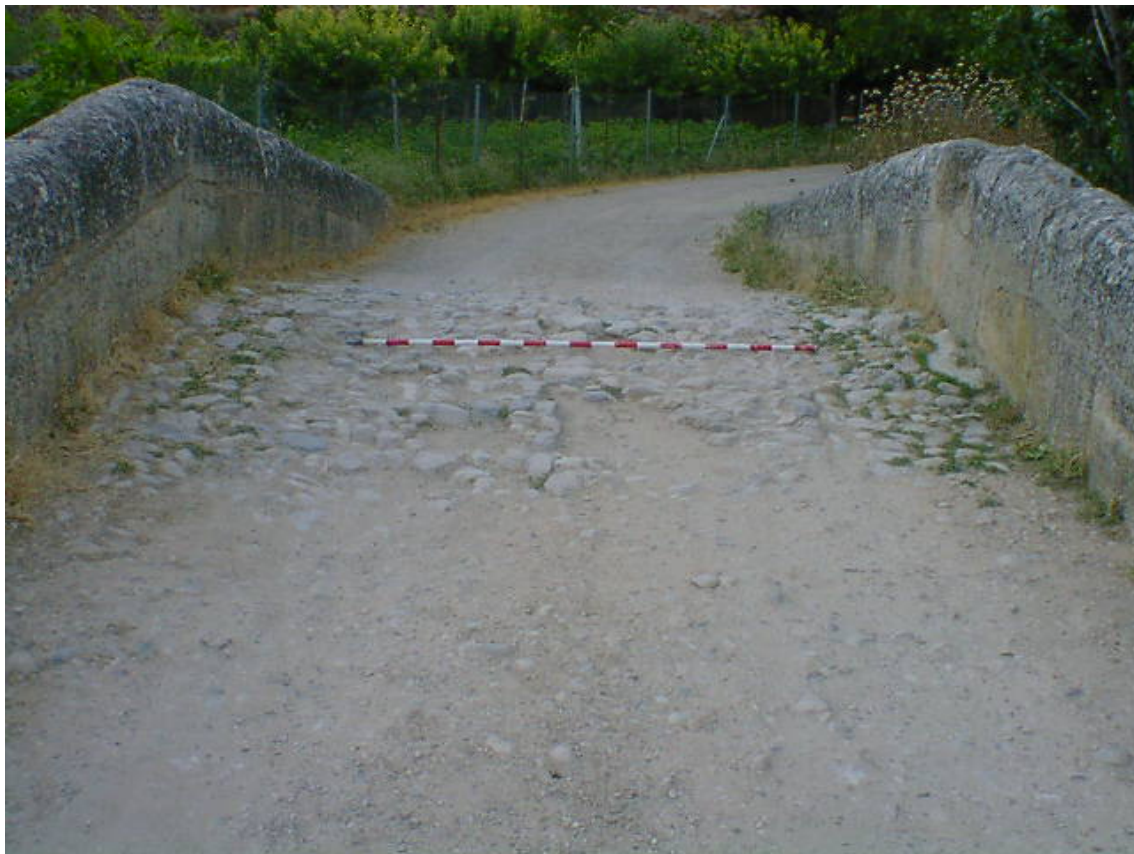
Fig 30. Empedrado y petriles del Puente del Allende.
