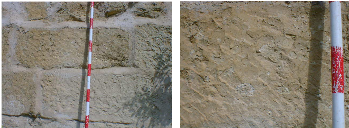
Fig 29. Sillares del zócalo de la subida al Puente del Allende (izquierda) y detalle de la marca de la gradina (derecha).
